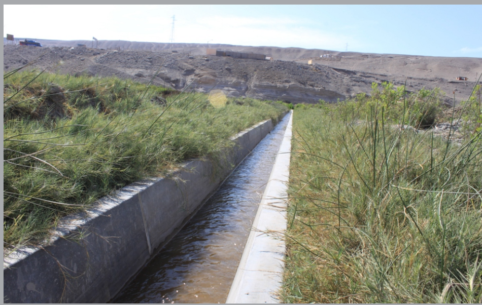
Tramo del canal La Aurora
