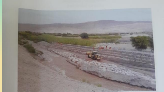
Foto 03 Muro de gavión culminado en cauce río Locumba
