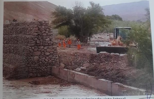
Foto 04 Muro de gavión culminado vista lateral
